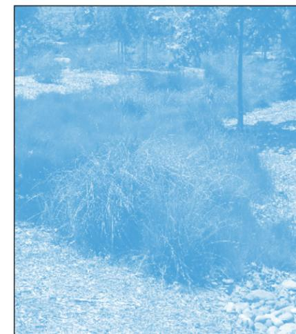
El agua del local fluye hacia las zanjas biológicas, mejorando así la infiltración y reduciendo la cantidad de contaminantes.
